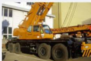
70t吊りクレーン
