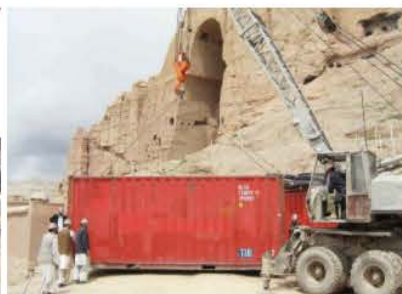
バミヤン（アフガニスタン）にて、タリバンの攻撃により崩壊した仏教遺跡（大仏像）の前でのクレーンを使用したコンテナ荷卸作業
